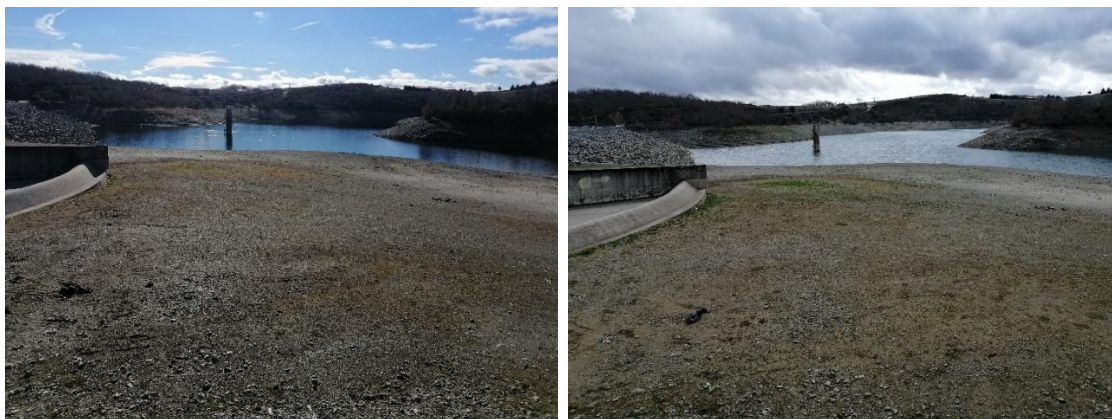
Barragem de Gostei, Bragança, zona de observação da Terra Fria: em 17 de fevereiro (esquerda) e em 22 de março de 2022 (direita). Fotos: Anabela Coimbra.
