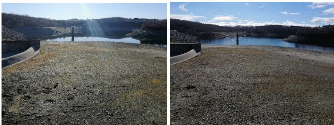
Fotos Anabela Coimbra: Barragem de Gostei em Bragança, zona de observação da Terra Fria, em 19 de janeiro de 2022 (foto da esquerda) e em 17 de fevereiro de 2022 (foto da direita). Esta baaragem está atualmente a ser alvo de obras de limpeza, manutenção e de melhoramento das infraesruturas.
