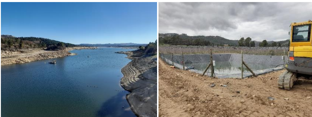
Fotos Rui Lagoa: Barragem do Vilar com nível da água atipicamente baixo (foto da esquerda) e construção de charca (foto da direita), na zona de observação do Beira Douro e Távora.
