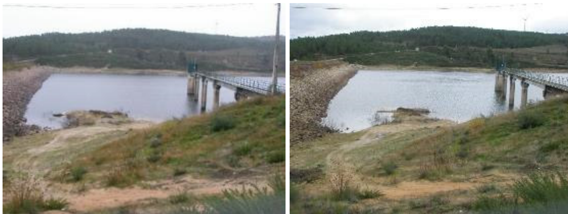
Fotos Manuel Sengo: Barragem de Lumiares em Armamar, zona de observação do Beira Douro e Távora, em novembro (foto da esquerda) e em dezembro de 2020 (foto da direita).
