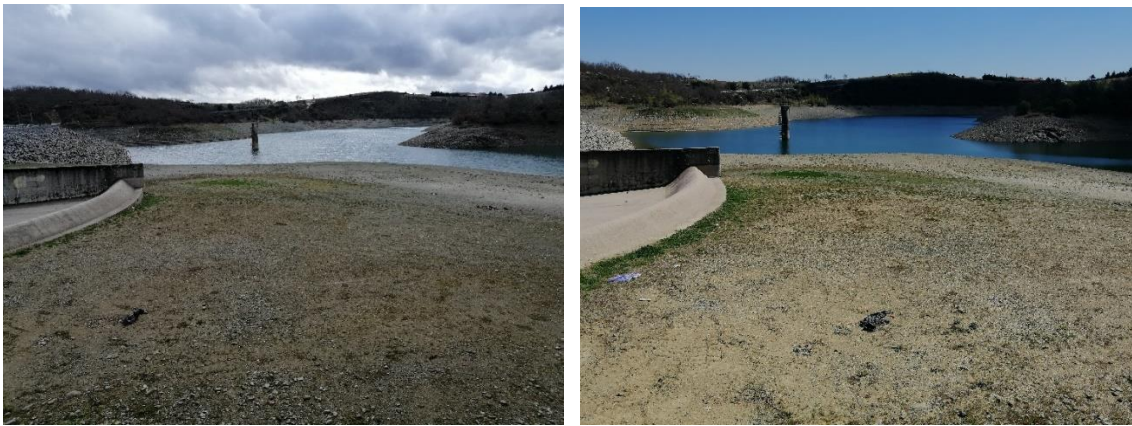
Barragem de Gostei em Bragança, zona de observação da Terra Fria: em 22 de março (esquerda) e em 18 de abril de 2022 (direita). Fotos: Anabela Coimbra.
