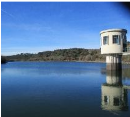
Figura 21. Nível de aprovisionamento hídrico, barragem de Penas Roias, 13.01.2025, Mogadouro
