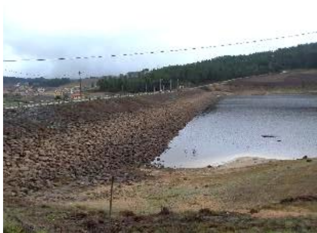
Figura 15. Nível de aprovisionamento hídrico, barragem de Temilobos, 21.01.2025, Armamar
