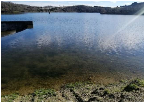
Figura 12. Barragem de Gostei, 19.01.2024, Bragança Fotos por: Anabela Coimbra
