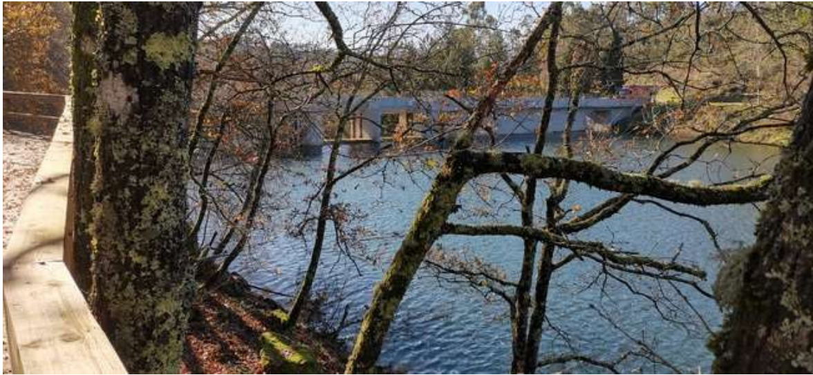
Figura 4. Barragem da Queimadela (Fafe) completamente cheia, zona de observação do Ave Foto por: Jerónimo Côrte-Real Santos
