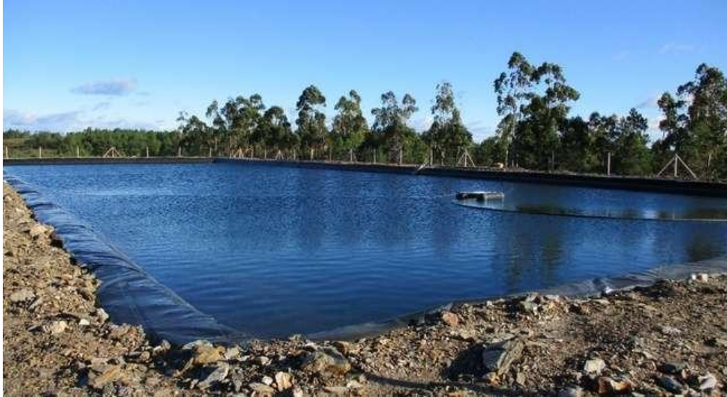
Figura 12. Charca impermeabilizada, localizada no ponto mais alto da zona, revelando a existência de recursos hídricos, Castelo Branco – Mogadouro Foto por: Miguel Martins
