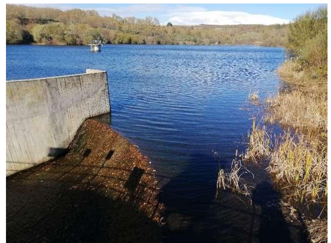
Figura 12. Barragem de Prada, 20.11.2024, Prada - Vinhais
